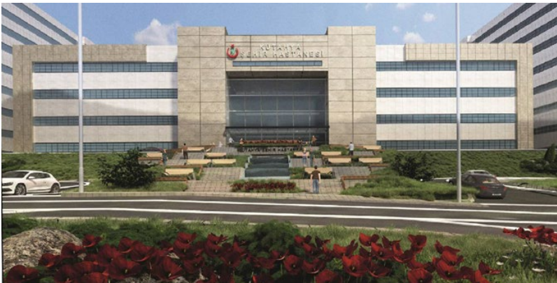
Kütahya Şehir Hastanesi
