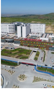
Yozgat Şehir Hastanesi
